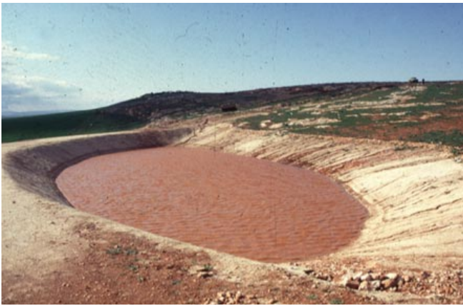
شكل 6. خزّان سطحي صغير لحصاد المياه من أجل الري التكميلي لمحاصيل حقلية شتوية في محطة بحوث إيكاردا بشمال سورية.
