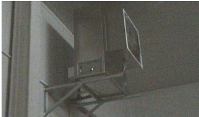
صورة 11. جهاز التريذ بالماء لزيادة الرطوبة النسبية للمخزن بالتحكم الآلي.
