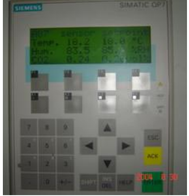
صورة 12. عرض بيانات درجة الحرارة والرطوبة النسبية ونسب الغازات لأحد غرف التبريد المتحكم فيها.
